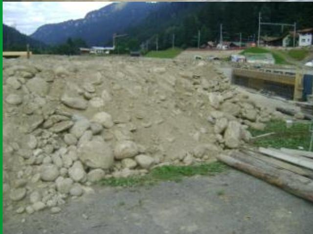
Güllenkasten wird ausgehoben, Material gelagert und Boden betoniert.
